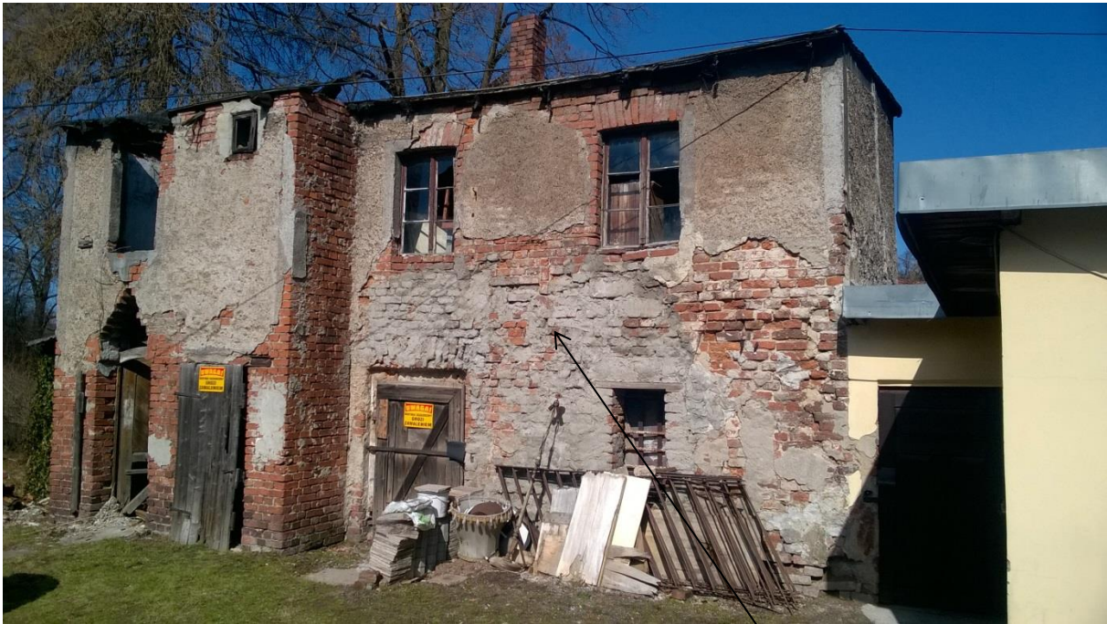
budynek gospodarczy do rozbiórki
